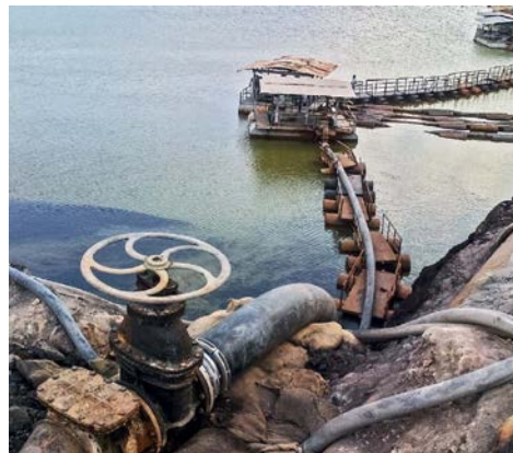
写真 7. 鉱山での排水処理
