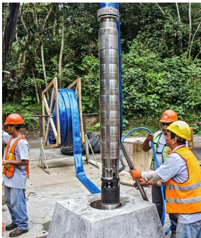
写真 4. 井戸水汲み上げ
