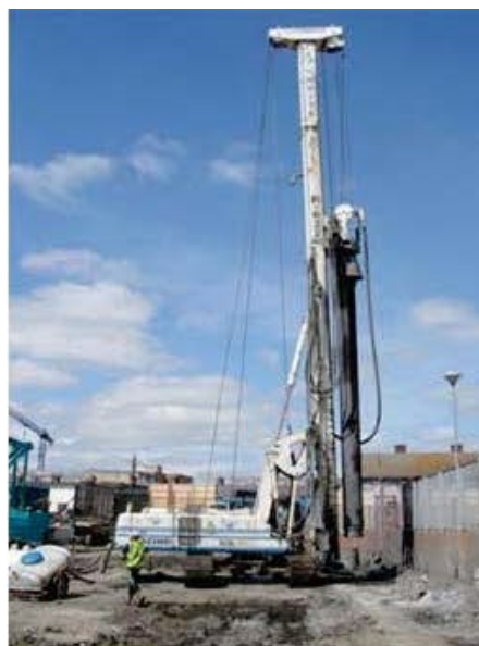
図 2.5 DTH ハンマーによる先行ボーリング
