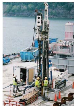
図 1.3 方向制御パイロット孔の施工
