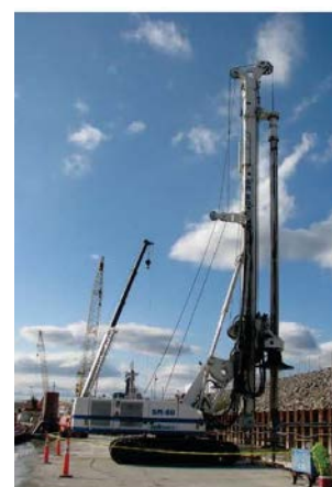
図 1.4 コンクリートダム本体を貫く削孔
