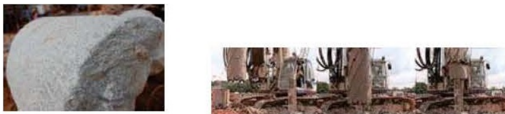
図 2.1 岩盤削孔用のコアバレルを装備した削孔リグ
