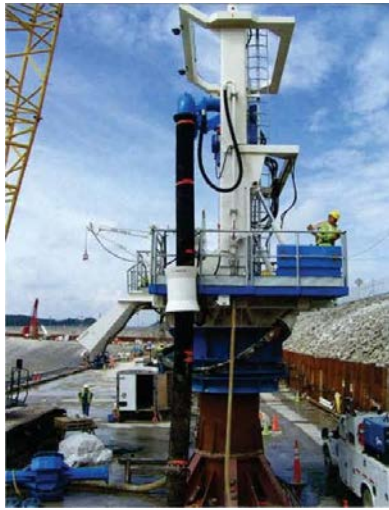
図 1.5 RCD による岩盤の削孔
